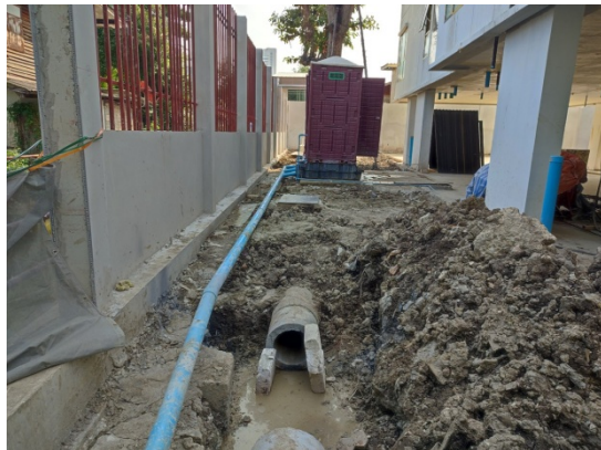
ภาพที่ 4-33 ก่อสร้างรั้วรอบโครงการและวางท่อระบายน้ำรอบโครงการ
