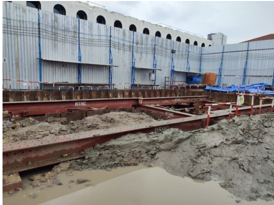
4-9 จัดทำระบบป้องกันดินพังด้วย Sheet Pile
