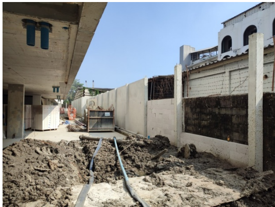
ภาพที่ 4-33 ก่อสร้างรั้วรอบโครงการและวางท่อระบายน้ำรอบโครงการ
