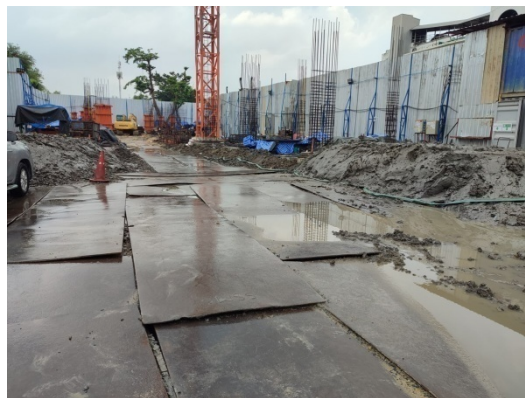
4-10 ปูแผ่นเหล็กหนาเป็นทางวิ่งรถภายในโครงการ
