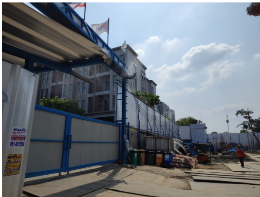
4-14 ติดตั้งสเปรย์น้ำเหนือรั้วฉีดพ่นละอองน้ำรอบโครงการเพื่อลดปริมาณฝุ่นละออง และวางระบายน้ำรอบโครงการ
