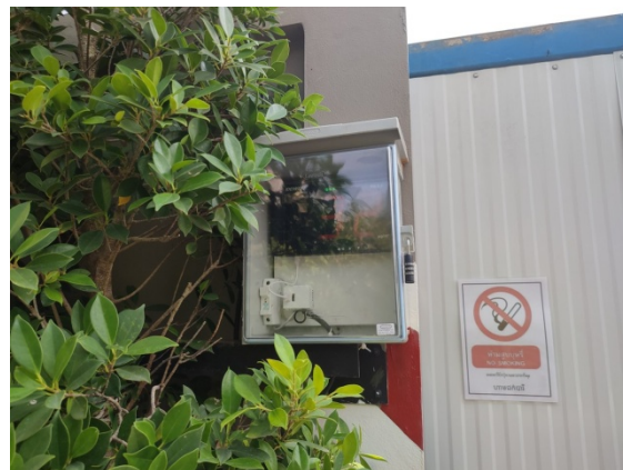
4-24 ติดป้ายแสดงค่าฝุ่นละอองในบรรยากาศแบบ real time ที่รั้วโครงการ
