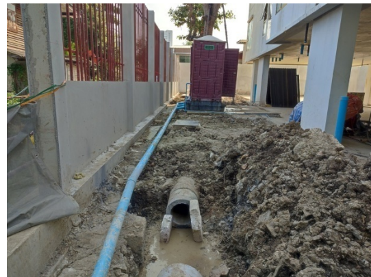
4-14 ติดตั้งสเปรย์น้ำเหนือรั้วฉีดพ่นละอองน้ำรอบโครงการเพื่อลดปริมาณฝุ่นละออง และวางระบายน้ำรอบโครงการ
